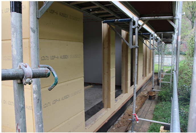
Ein Anbau an der Nordseite schafft zukünftig Platz für zwei Schlafräume.
